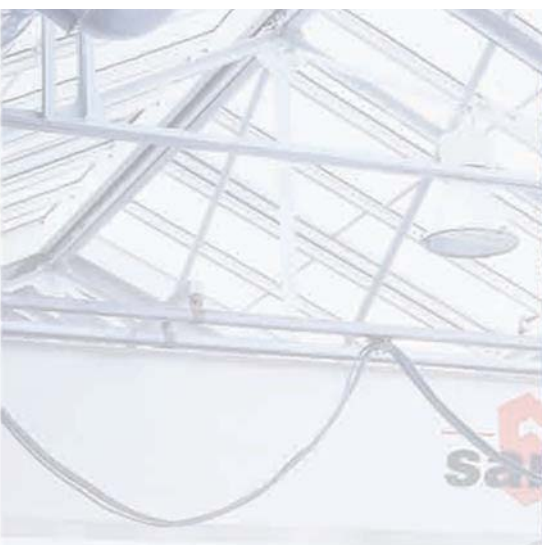
Fondazione Arnaldo Pomodoro-Milano. Carroponte bitrave a cassone. Portata 10000 Kg. Scartamento 10 mt.
